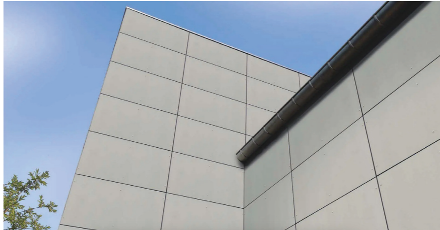
Szálcement burkolólemez 32 MPa hajlító-húzószilárdsággal
